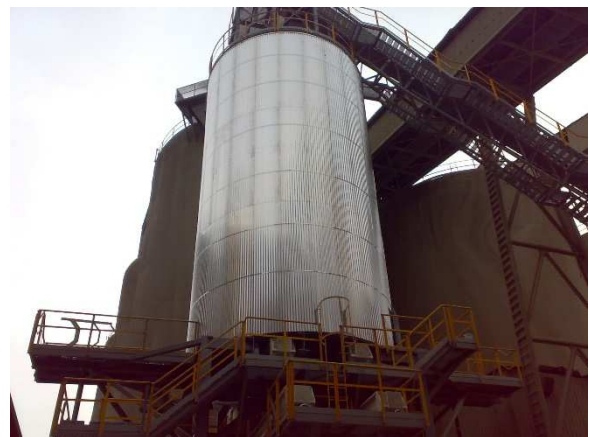
Instalación de Biomasa Planta CEMEX (Alcanar)
