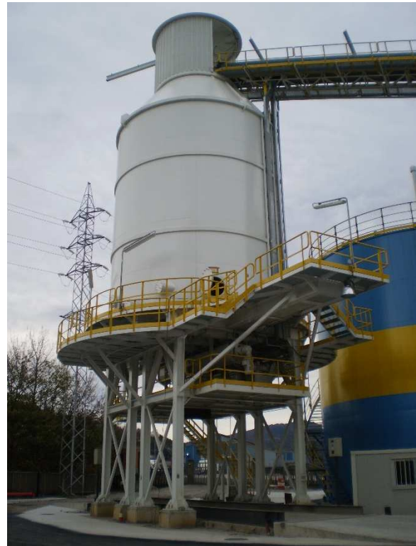
Transporte y almacenamiento de yeso de desulfuración
