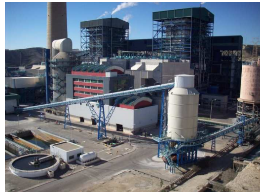
Transporte y almacenamiento de yeso de desulfuración
