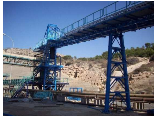
Cinta transportadora de yeso
