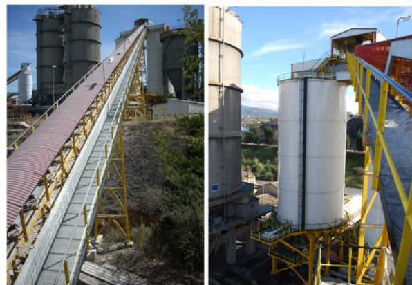
Transporte y almacenamiento de yeso de desulfuración
