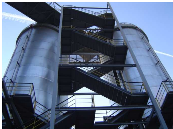
Silos de almacenamiento de fangos
