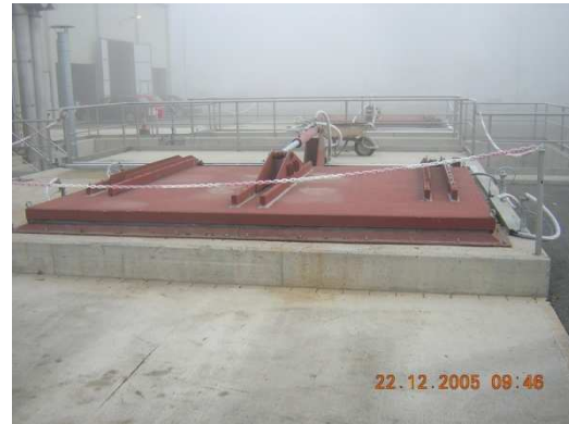
Tolvas de recepción de fango deshidratado
