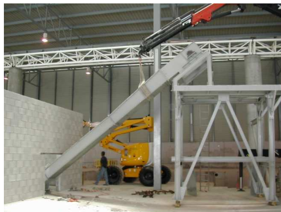
Transportador de cadena para fango deshidratado
