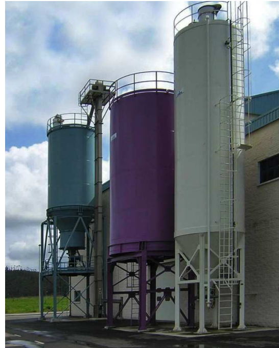
Transporte y almacenamiento de fangos de depuradora E.D.A.R. MAQUA
